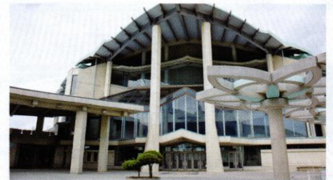
沖縄コンベンションセンター劇場棟
